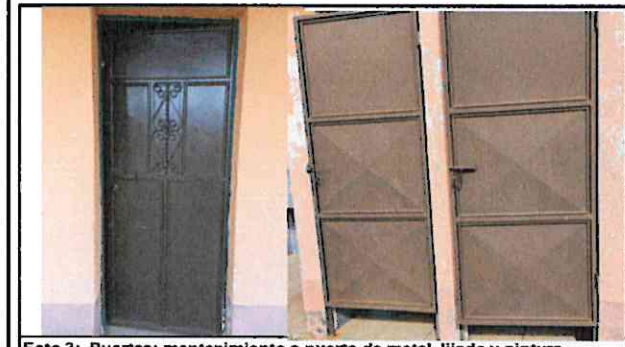
Foto 3: Puertas: mantenimiento a puerta de metal, lijado y pintura.
