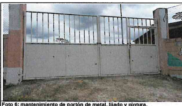
Foto 6: mantenimiento de portón de metal, lijado y pintura.
