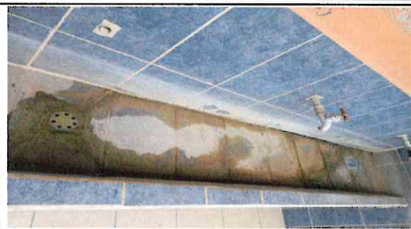
Foto 7: Reparación o sustitución de azulejos
