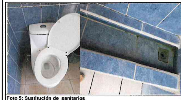
Foto 5: Sustitución de sanitarios
