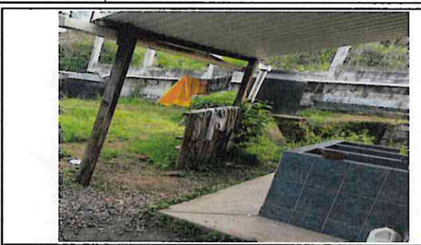
Foto 2: Estructura de techo: sustitución de estructura de madera por metal.
