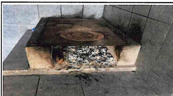
Foto 10: sustitución de plancha de 3 hornillas por plancha de 3 hornillas.
