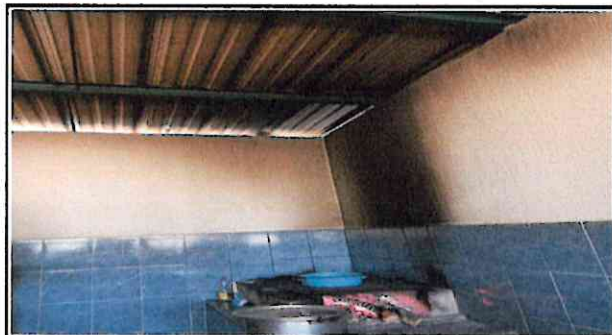
Foto 9: Reparación áreas de cocina: chimenea con tubo de concreto.
