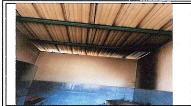
Foto 1: Cubierta de lámina: sustitución de lámina troquelada por lámina troquelada
